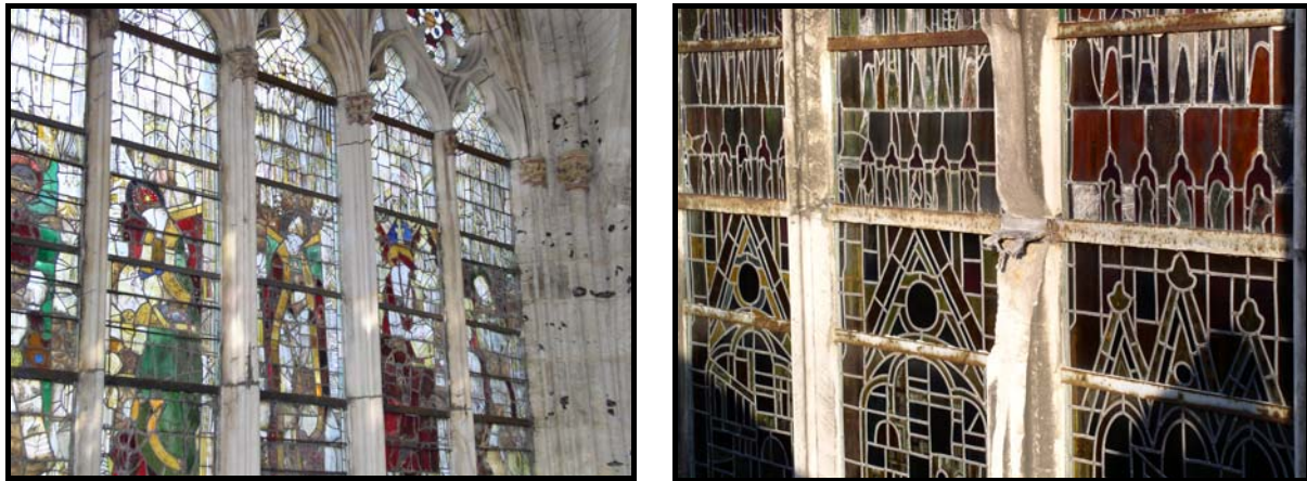
Figure 6 : Détail de l'armature de vitraux du chœur de l'église Saint-Ouen de Rouen montrant des barlotières-tirants de plus forte section.
