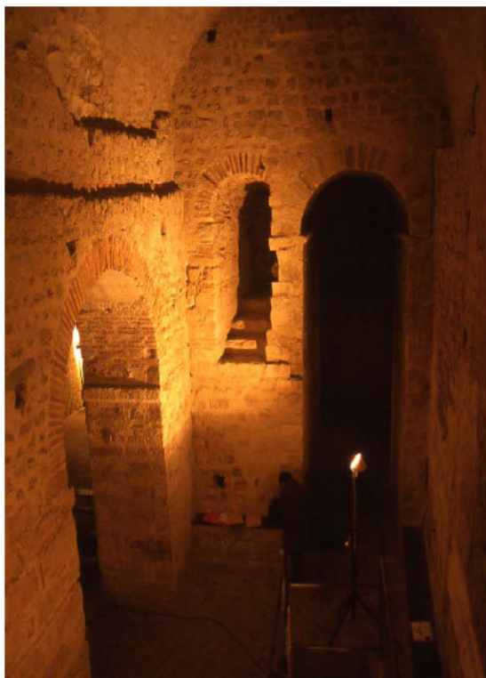
figure 1 : Notre-Dame-sous-Terre, Mont-Saint-Michel (Manche, France). Vue intérieure depuis la tribune. On distingue à gauche le mur médian (dit de refend) qui sépare les deux nefs de la chapelle. Fenêtres et arcs comportent des briques qui sont l'objet de cette étude. (Photo PG, IRAMAT-CRPAA, CNRS)
