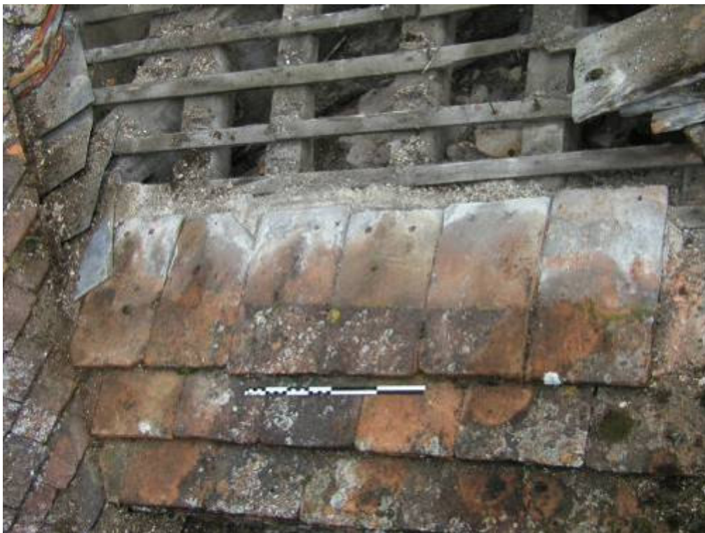
Fig. 6 : Pontigny (Yonne), porche de l'abbatiale (2004). Tuiles sans crochet au moment de leur découverte pendant la dépose de la couverture (cl. S. Aumard).
