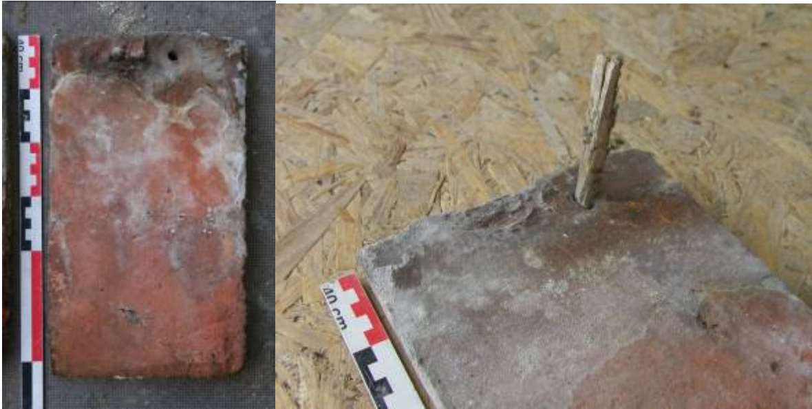
Fig. 9 : Vermenton (Yonne), église Notre-Dame. Tuiles à crochet non retroussé et perforation soignée prévue pour recevoir une cheville en bois parfois conservée (cl. S. Aumard).
