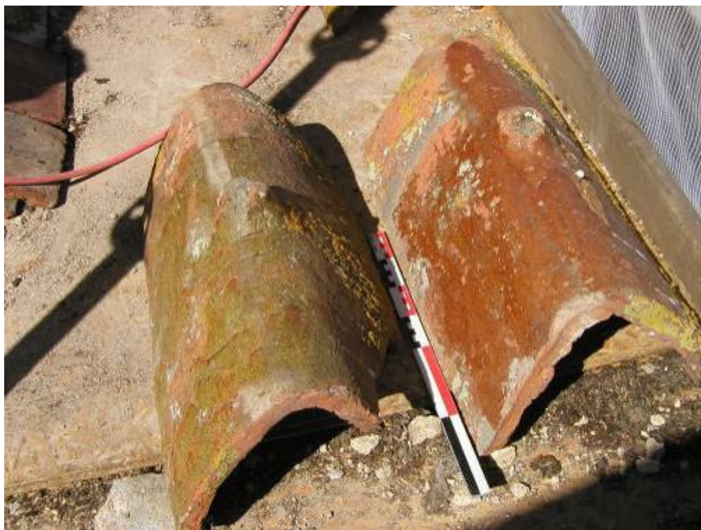
Fig. 8 : Vermenton (Yonne), église Notre-Dame. Tuiles faîtières en provenance de la couverture du chœur. Travaux de 2004 (cl. S. Aumard).
