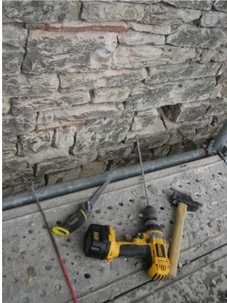
Fig. 4 : Un petit équipement composé principalement d'une lame de scie et d'une perceuse munie d'une grande mèche permet de découper le mortier autour des tuiles remployées dans les maçonneries. Combinée à l'analyse des élévations, cette technique permet d'alimenter efficacement les typoschronologies (cl. S. Aumard).
