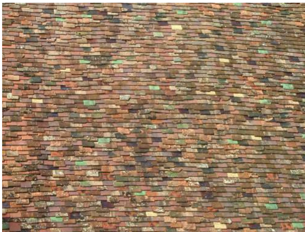
Fig. 2 : Auxerre (Yonne), cathédrale Saint-Étienne, toiture du chœur. La diversité des coloris et des formats illustre les réparations successives depuis l'origine de la couverture et indique un fort potentiel historique (cl. S. Aumard).
